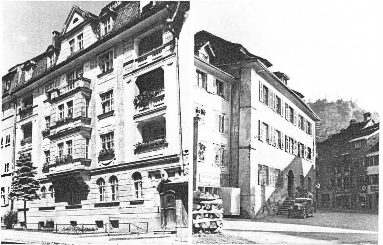
AK-Büro, seit 1925 im 1. Stock der Gilms- straße. Ebenerdig die Bibliothek. (Stadtarchiv Feldkirch)
