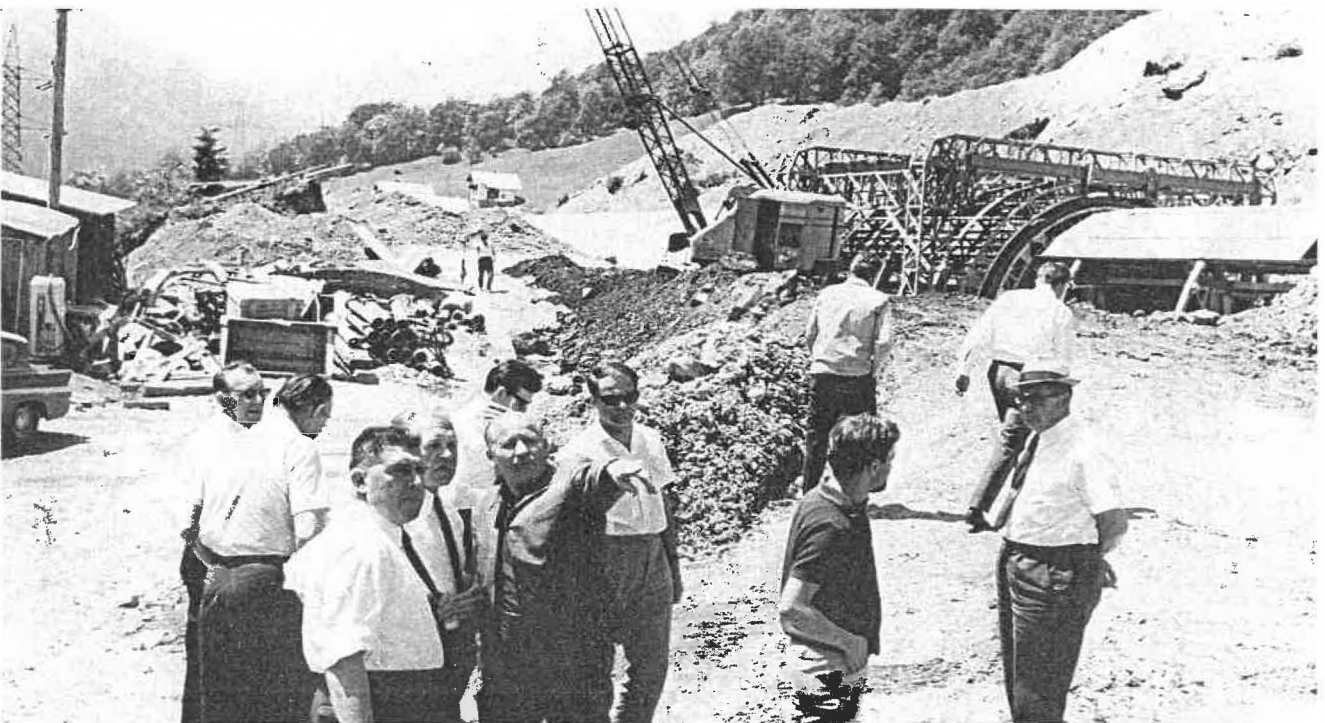
Der verkehrspolitische Ausschuß der Arbeiterkammer besichtigt Straßenbauten im Ländle. Im Vordergrund Hofrat Dipl.-Ing. Nötzold, Leiter des Straßenbauamtes. Baustelle: Passürtobel tunnel (1968).
